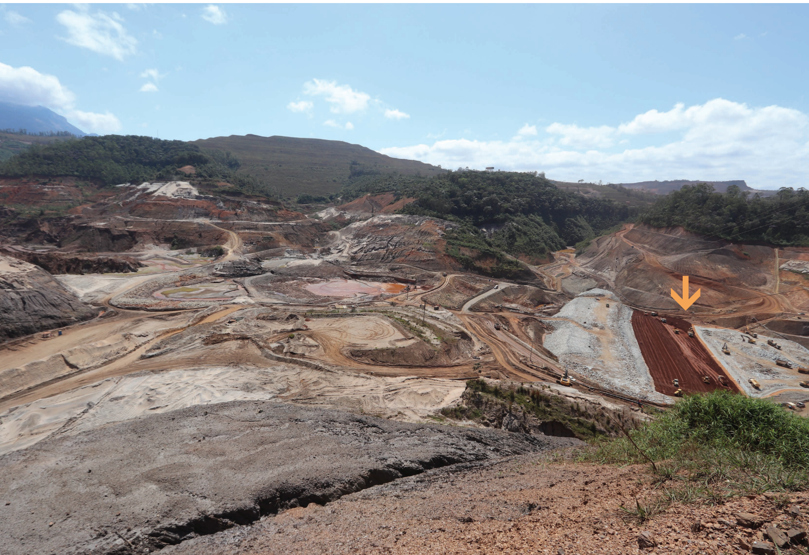
Figura 1. Vista do local da Barragem de Fundão. À direita, uma barragem permanente (denominada S1) está sendo construída para conter os rejeitos remanescentes no local. Essa barragem faz parte das ações determinadas pelos órgãos do governo para tratar da gestão de rejeitos (outubro de 2018).
