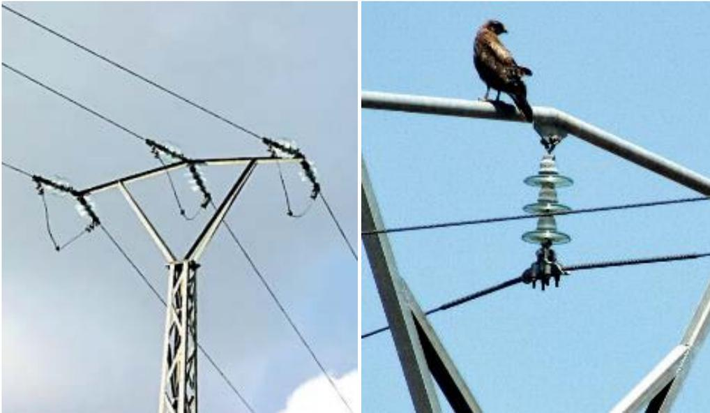
Photos 27 et 28. Pylônes de Type « G » dont les traverses en forme de voûte sont dotées d'isolateurs suspendus ou en chaîne d'ancrage avec bretelles de liaison en dessous, à une distance de moins de 0,88 m entre le sommet inférieur de la voûte et le conducteur ou la bretelle ; exemple d'isolation efficace et recommandée sur le conducteur central (Photo 27 © JRG et Photo 28 © IF).
