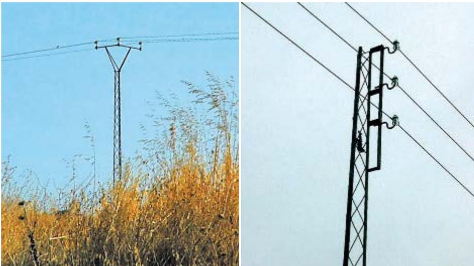
Photos 34 et 35. Les lignes dotées de conducteurs situés sur un seul plan horizontal (à gauche) présentent un risque de collision avec les oiseaux inférieur à celui des lignes aux conducteurs situés sur trois plans ou plus (à droite) (Photo © JRG).
