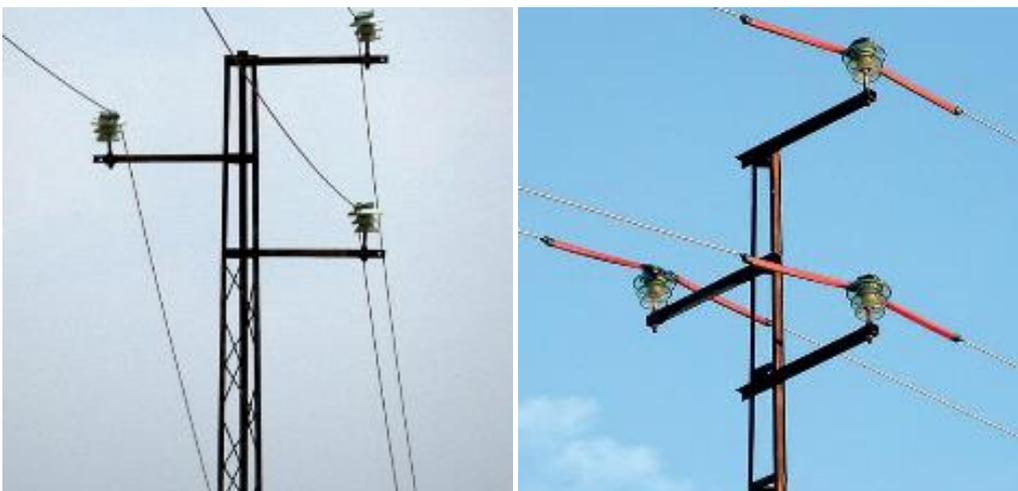
Photos 17 et 18. Pylônes de Type « B » dotés de traverses comportant des isolateurs rigides et avec l'isolation recommandée (Photo © JRG).
