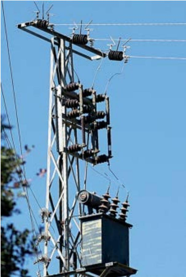
Photo 5. Pylône doté d'un sectionneur sur le poteau et d'un transformateur sur la partie inférieure (Photo © JRG).
