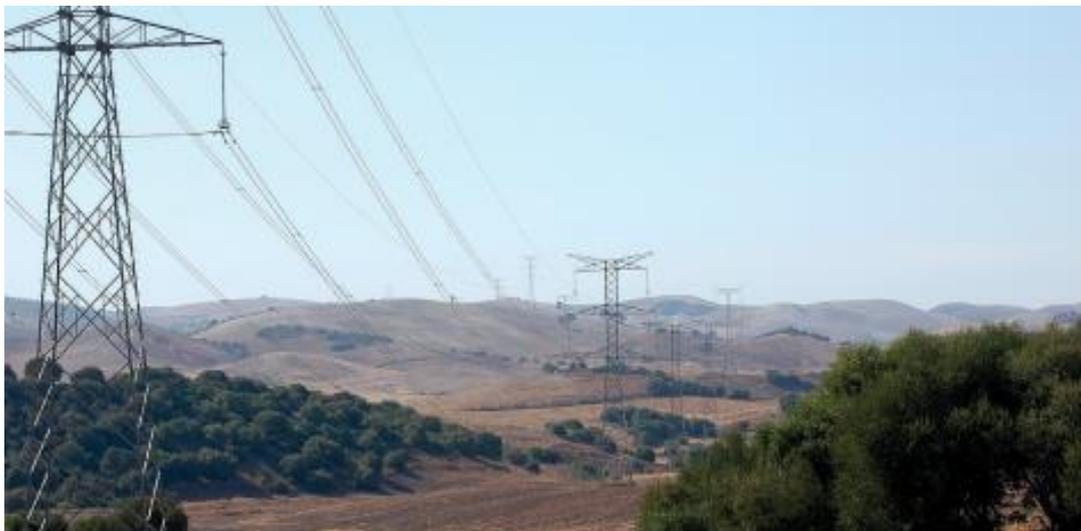
Photo 3. Ligne de transport. On peut distinguer les câbles de terre, moins épais, sur la partie supérieure (Photo © JRG).
