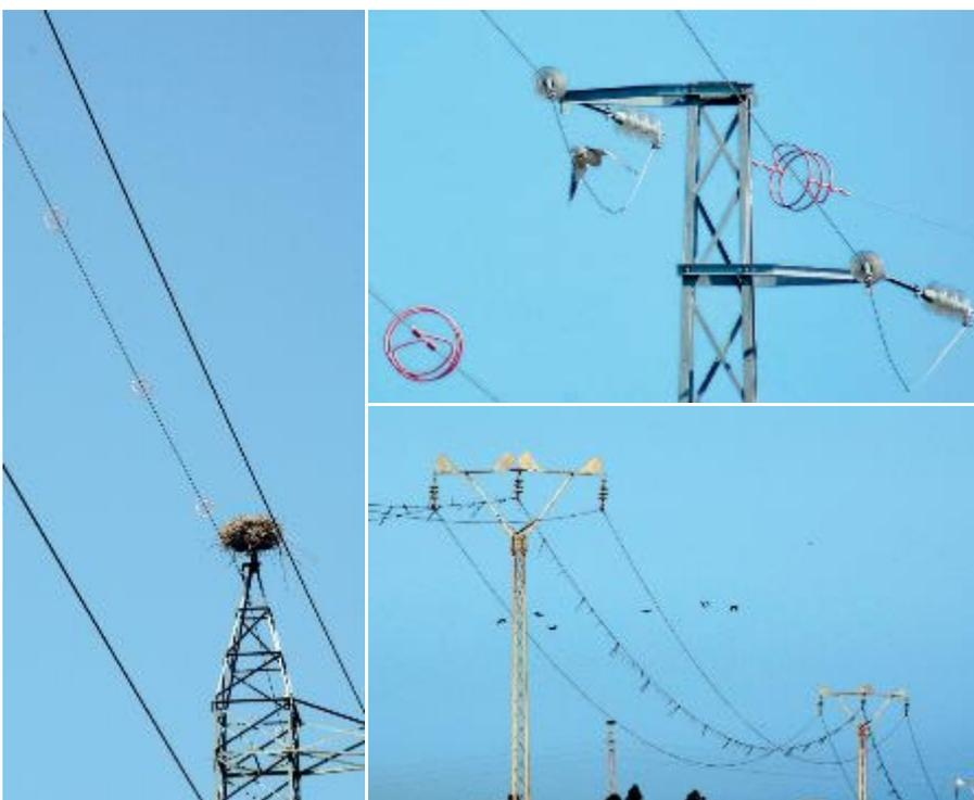
Photos 36, 37 et 38. Les balises anticollision reliées au conducteur et les unes aux autres (photo en bas à droite) sont beaucoup moins efficaces que les balises en forme de spirale, appelées « queues de cochon » (à gauche et en haut à droite) (Photos 36 et 37 © JMMZ ; Photo 38 © JRG).
