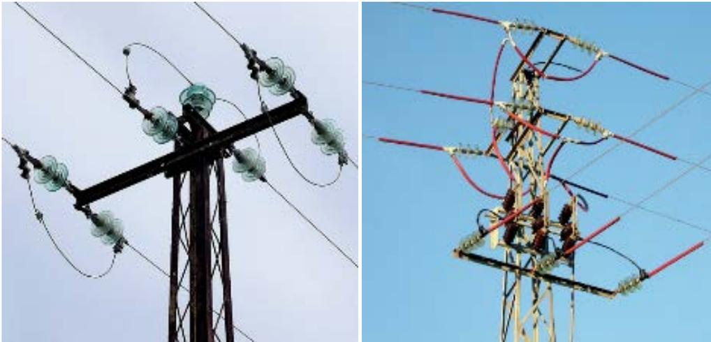
Photos 19 et 20. Pylônes de Type « C » dont les traverses sont dotées de bretelles au-dessus des conducteurs dans tous les cas et lorsque les traverses sont dotées d'isolateurs en chaîne d'ancrage à une distance inférieure à 0,75 m entre les conducteurs de chaque côté de la traverse, et avec l'isolation recommandée (Photo © JRG).
