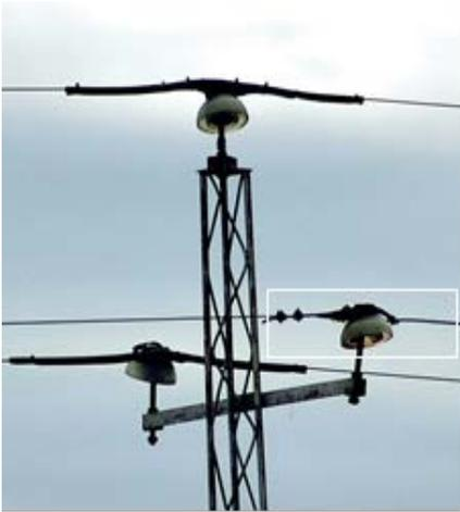
Photo 29. Perte d'efficacité de l'isolation des conducteurs, laquelle se détériore au fil du temps et en raison des intempéries, et finit même par disparaître (Photo © JRG).
