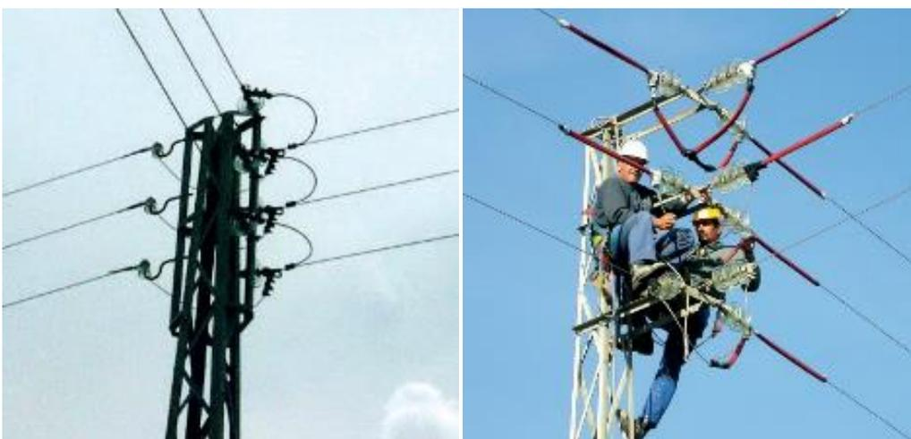
Photos 21 et 22. Pylônes (de dérivation) de Type « D », avec l'isolation recommandée (Photo © JRG).
