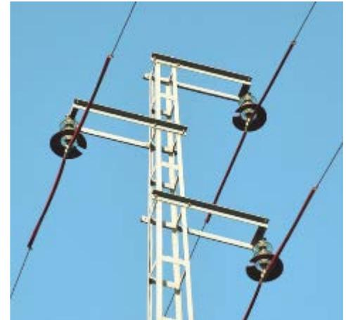
Photos 30 et 31. L'isolation des conducteurs latéraux situés sur les pylônes dotés de traverses en forme de voûte et d'isolateurs suspendus (à gauche), et des conducteurs situés sur les branches intermédiaire et inférieure des pylônes dotés de traverses en quinconce et d'isolateurs suspendus constituent un gaspillage des ressources économiques car il n'y a pas de risque de contact entre les conducteurs et les oiseaux qui y sont perchés (Photo 30 © IF et Photo 31 © JRG).
