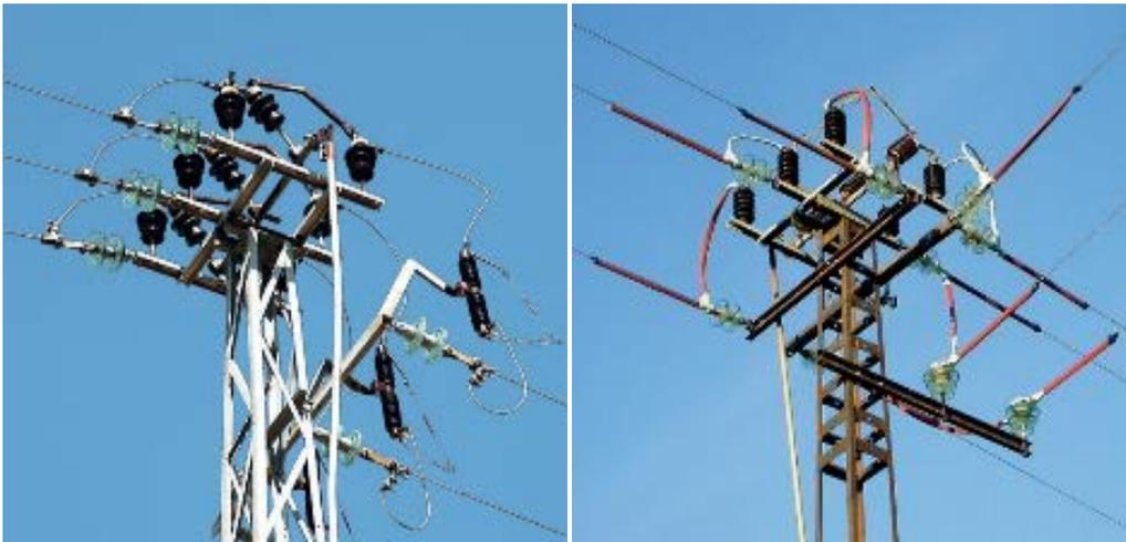
Photos 15 et 16. Pylônes de Type « A » dotés de sectionneurs à l'air libre, positionnés au niveau du sommet ou du poteau, sur les traverses, avec l'isolation recommandée (Photo © JRG).
