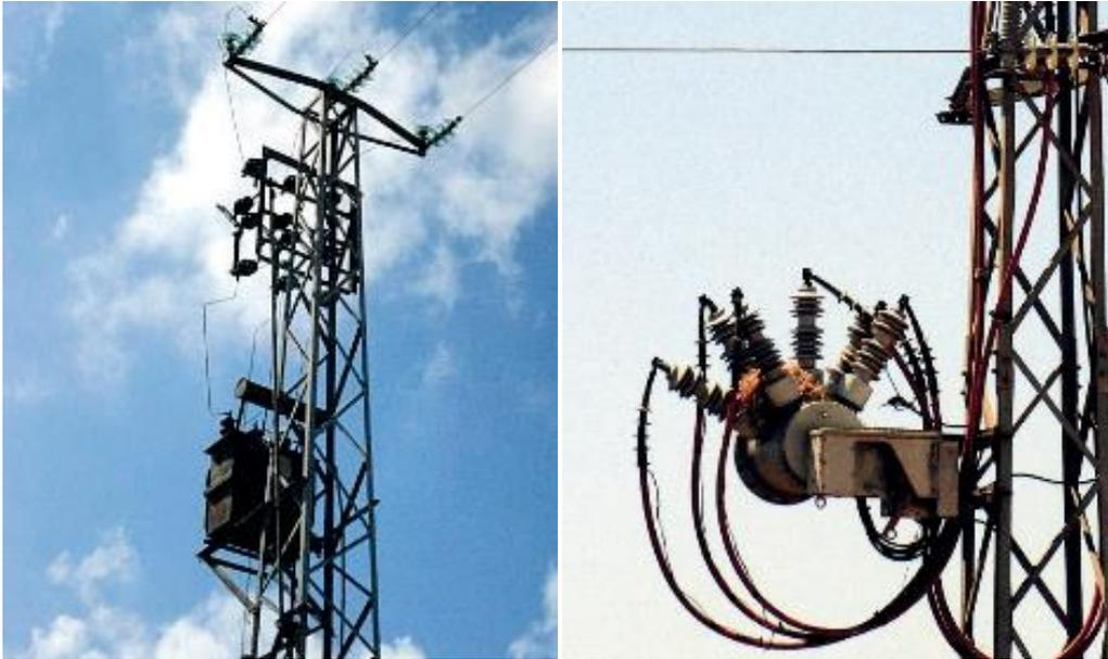
Photos 23 et 24. Pylônes de Type « E » dotés de transformateurs extérieurs et avec l'isolation recommandée, incluant des conducteurs allant de la traverse au transformateur (Photo 23 © JRG et Photo 24 © JMMZ).
