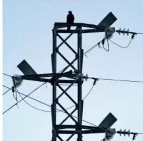
Photo 14. Plaques de dissuasion empêchant les oiseaux de se poser sur les parties dangereuses de la traverse, les conducteurs (Photo © IF).
