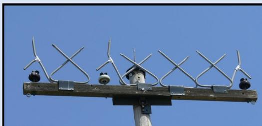
*En haut : pour prévenir ces risques, il faut que les dispositifs de dissuasion ne soient pas métalliques (images de modèles utilisés dans l'UE).*
