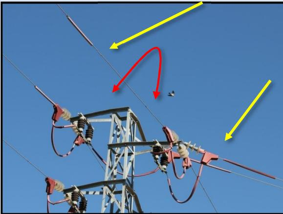
*À gauche : la gaine utilisée comme isolant s'est détachée de l'agrafe (probablement en raison d'une installation défectueuse) et s'est déplacée, laissant apparaître des parties du câble non protégées et très proches du pylône.*
