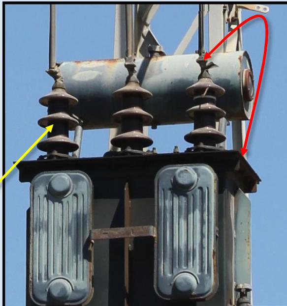
*À gauche et en haut : les transformateurs non couverts ou sans capuchon isolant à la jonction avec les conducteurs présentent un risque d'électrocution si un oiseau se pose sur l'élément métallique et touche les conducteurs.*
