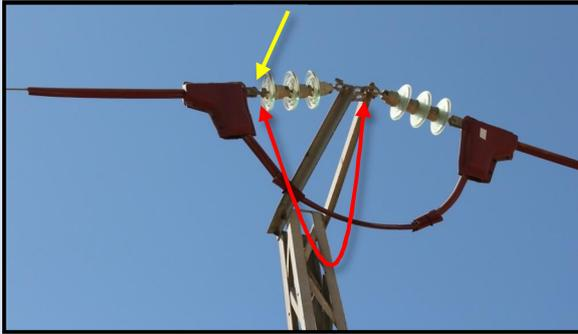
*À gauche : les attaches qui recouvrent l'élément métallique sont mal installées et laissent apparaître une partie métallique. Il y a un risque d'électrocution si l'oiseau effleure cette partie en se posant sur le poteau métallique.*
