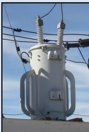
*À gauche : exemple de transformateurs dont les éléments conducteurs sont entièrement couverts et qui ne laissent aucun élément métallique à l'air libre.*
