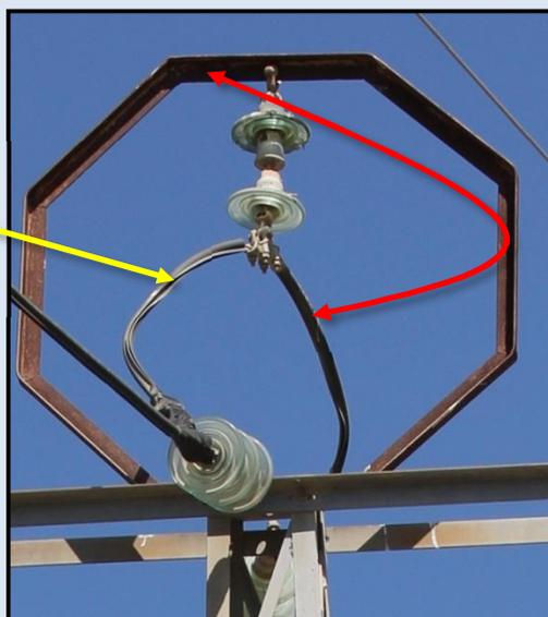
*À gauche et en haut : pylône sur lequel les conducteurs latéraux sont isolés mais pas la bretelle métallique située juste en dessous du support. Plusieurs rapaces et corvidés sont morts à proximité de ce poteau, ce qui ne semble pas être arrivé par hasard mais à cause de cette défaillance.*
