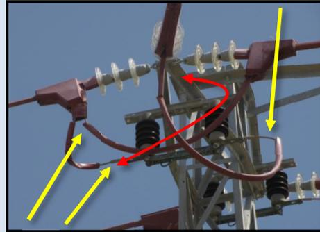
*À droite : rectification similaire à la précédente ; même si l'attache est ici bien située, les isolants laissent apparaître des parties de câbles.*
