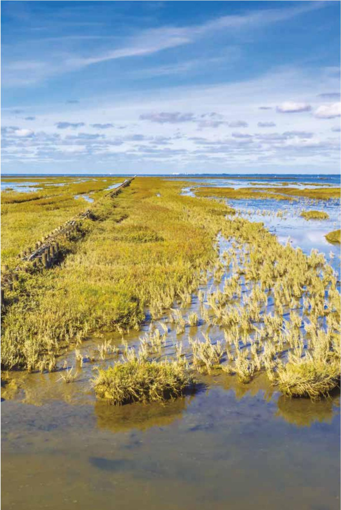
La protección del hábitat de una marisma puede lograrse con gran plausibilidad técnica colocando represas de madera a lo largo del borde de erosión. Estos dispositivos protegen contra la energía de las olas y causan la retención de los sedimentos. Esta restauración activa puede prevenir una mayor erosión de la marisma salada
