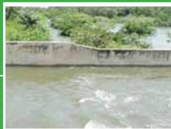
Déversoir du barrage du Confluent en période de crue
