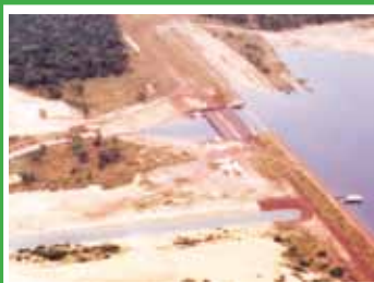
Vue aérienne du barrage de Niandouba
