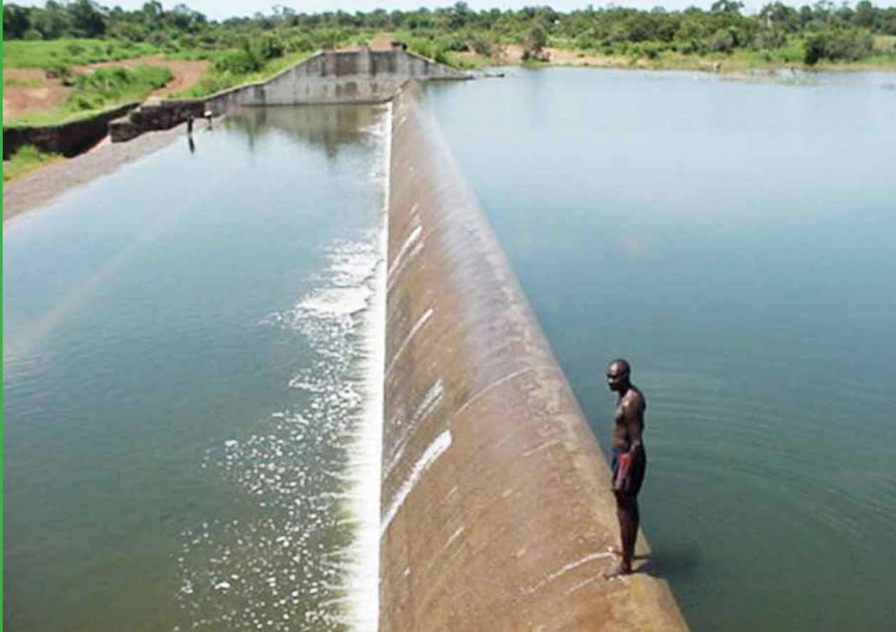
Déversoir du barrage de Niandouba ( crédit photo : SODAGRI )
