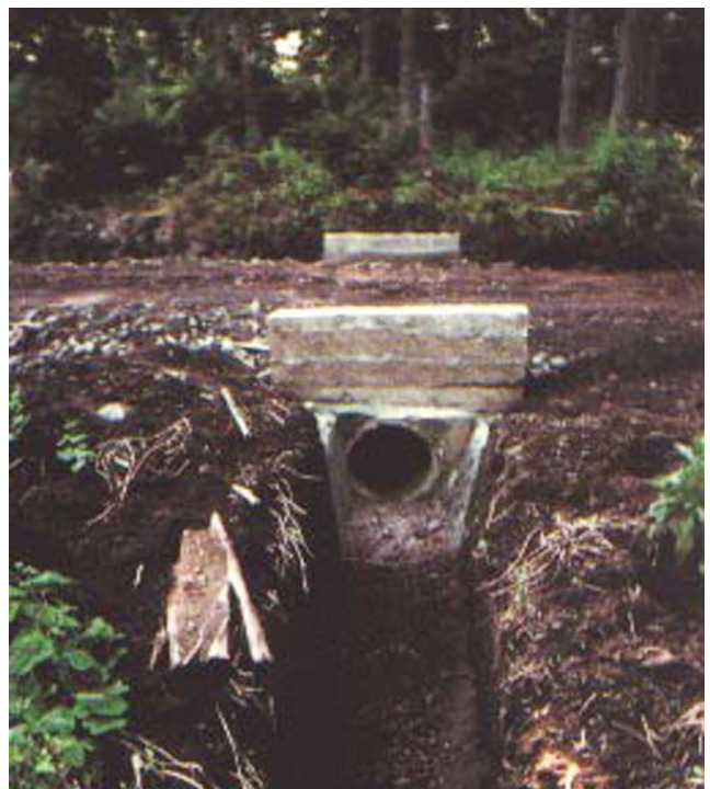
სურათი 10. გზების დრენირების სისტემა არ უნდა იყოს ძვირადღირებული. მათი ერთადერთი დანიშნულებაა ეფექტურობა
