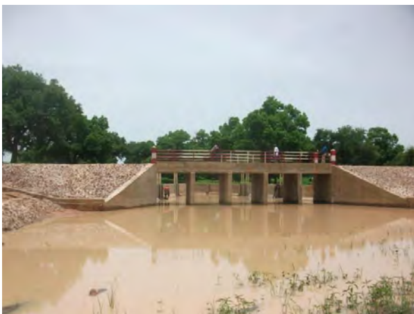
Ouvrage de retenue d'eau de Pathiap, à Tambacounda.
